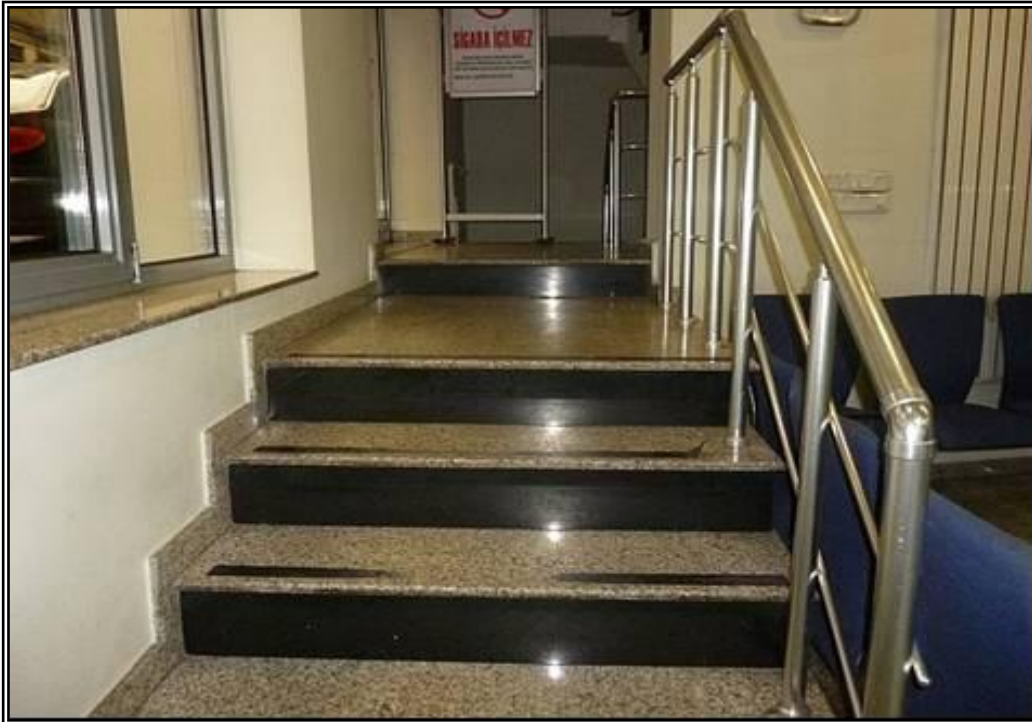
Zemin kattan katlara çıkan ara merdiven
